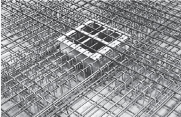
Die vierte Lage, d.h. die zweite Lage der oberen Längsbewehrung wird verlegt.
