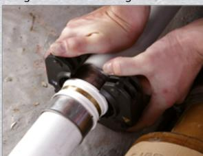
Greifen der Pressschlinge mittels Zwischenbacke
