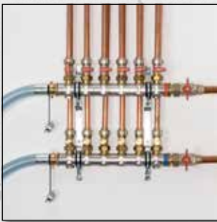
Spülen von Radiatoren- und Flächenheizsystemen (S/SL/SLW)
