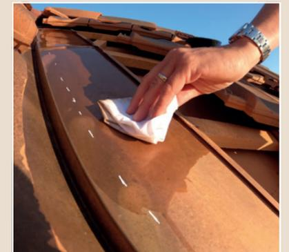
Die **Marder® Protect™** Profile können Öffnungen im Dach von bis zu **50 mm** verschliessen.
