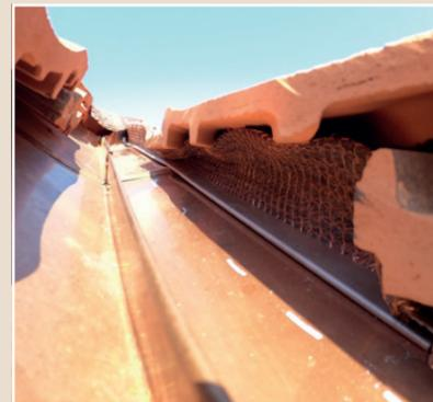
Bei grossen Öffnungen, kleinen Ziegelspickeln und maximaler Streckung des **Marder® Protect™**, empfehlen wir den punktuellen Einsatz eines Montageklebers.
